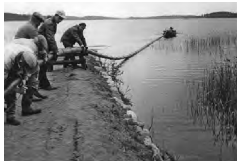
En roddbåt och rejält med manuell arbetskraft var vad som behövdes för att få ner det här röret i vattnet.
